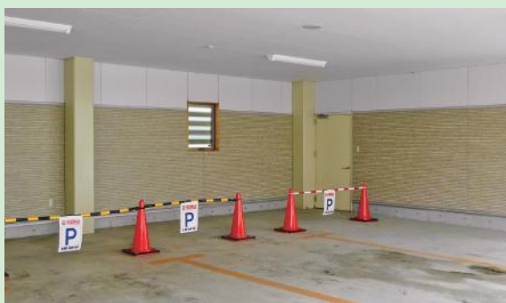
腰壁補強後のピロティ
